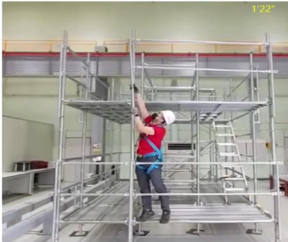
<수평 선행안전난간대 설치 영상>
