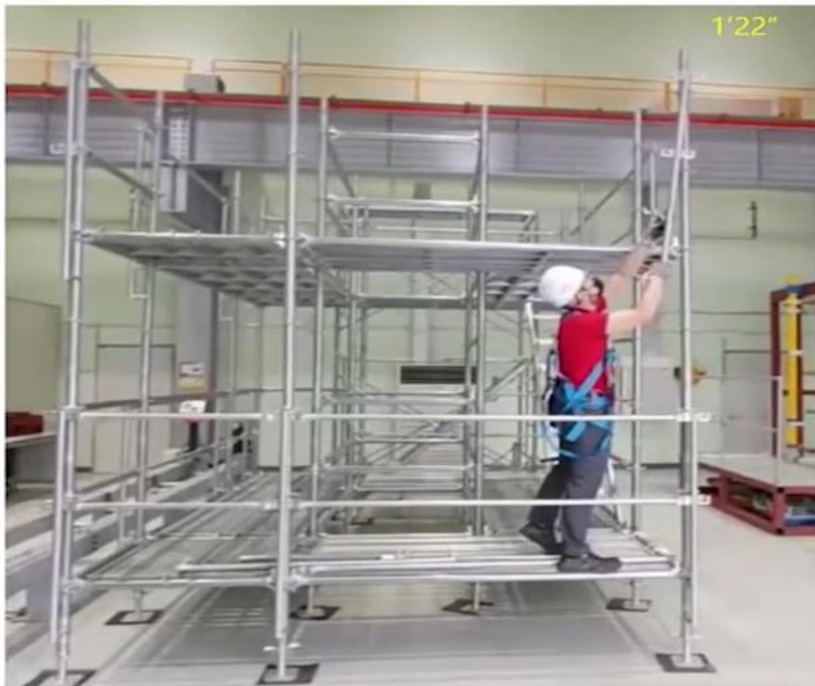
<수평 선행안전난간대 설치 영상>
