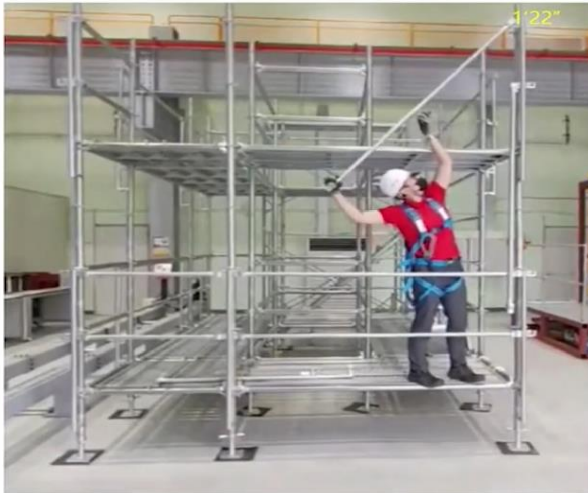
<수평 선행안전난간대 설치 영상>
