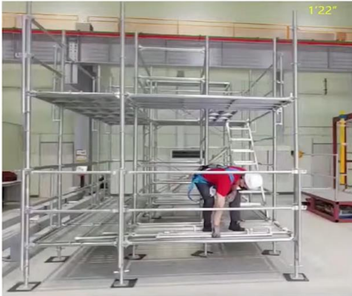
<수평 선행안전난간대 설치 영상>
