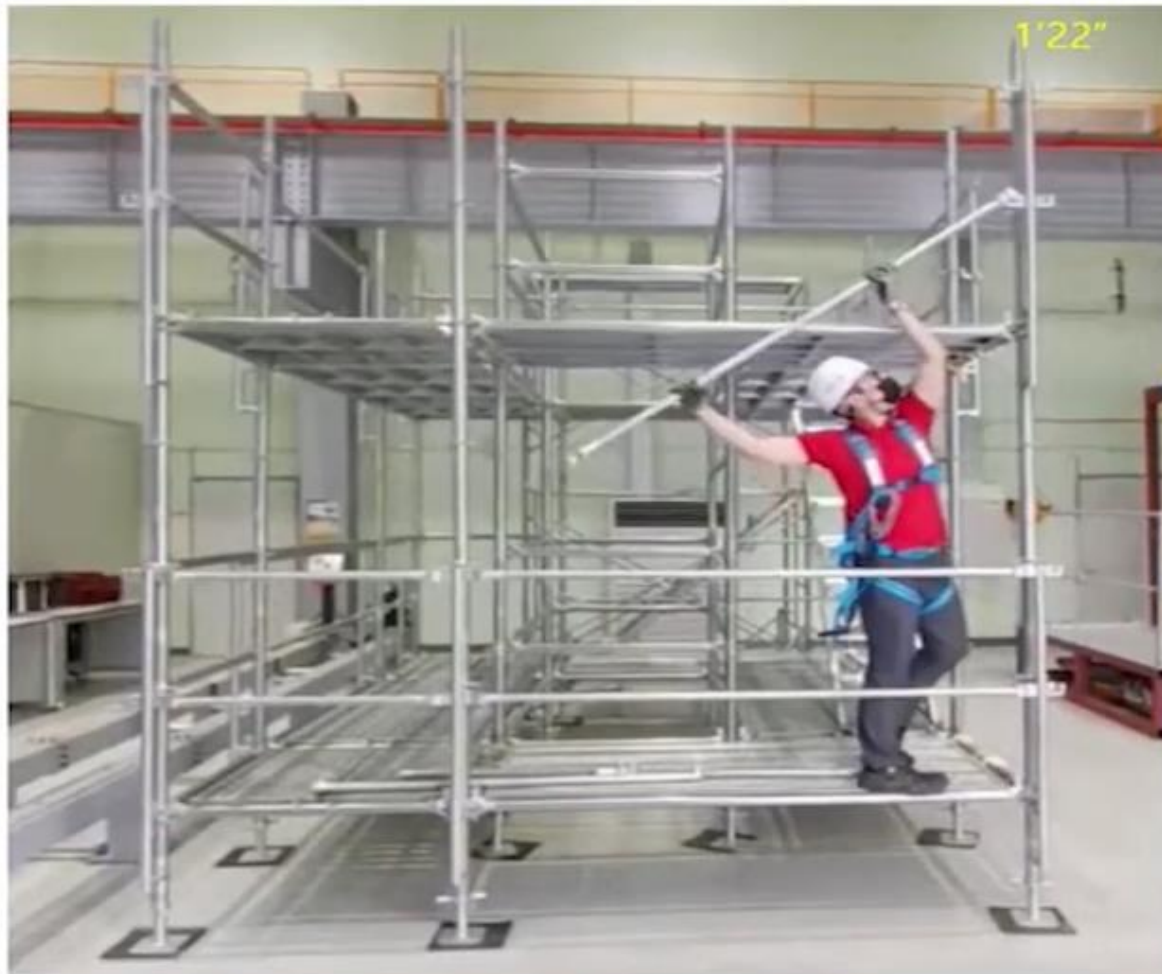
<수평 선행안전난간대 설치 영상>
