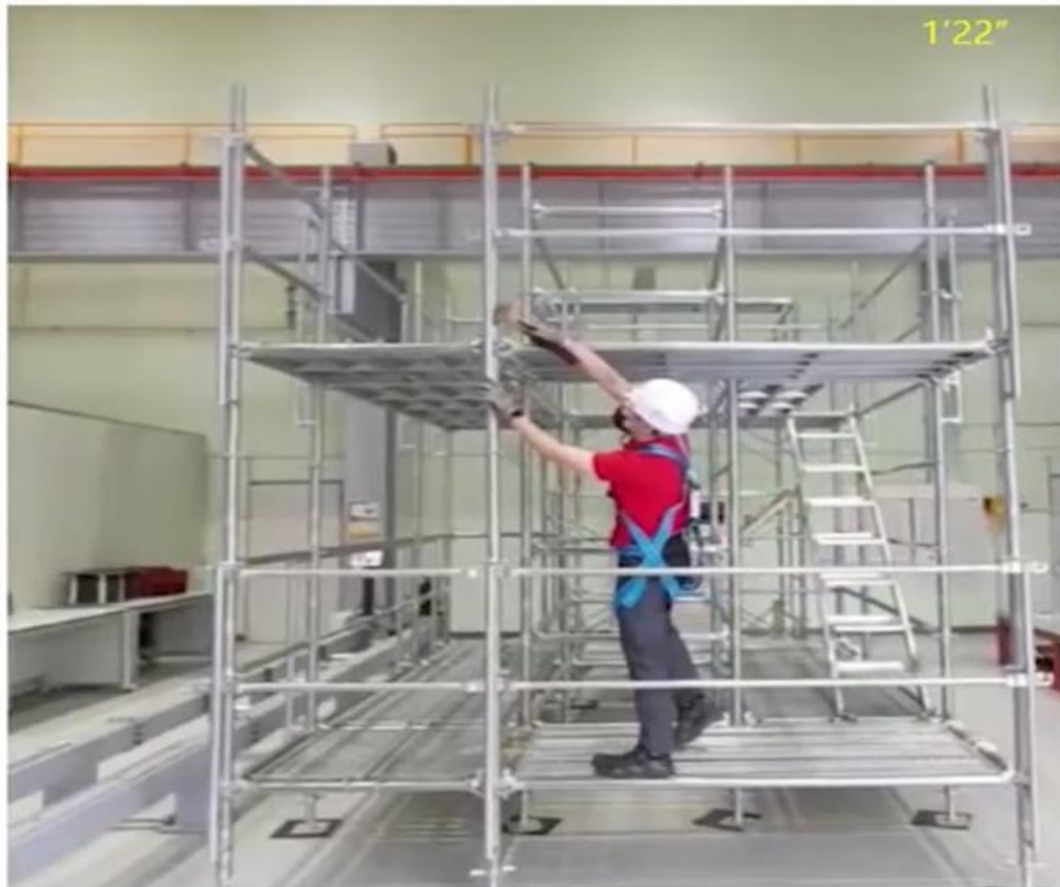
<수평 선행안전난간대 설치 영상>
