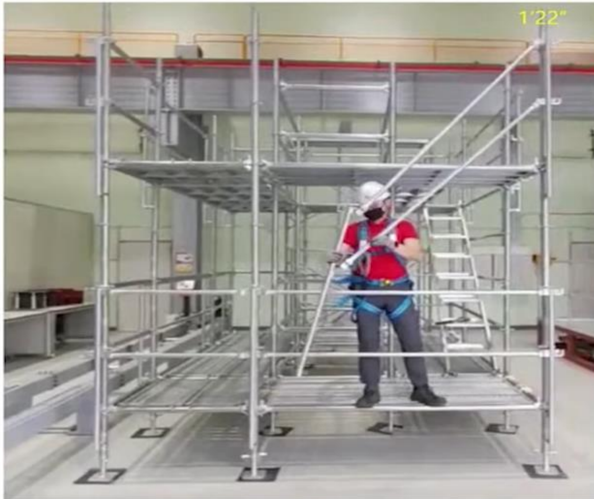
<수평 선행안전난간대 설치 영상>
